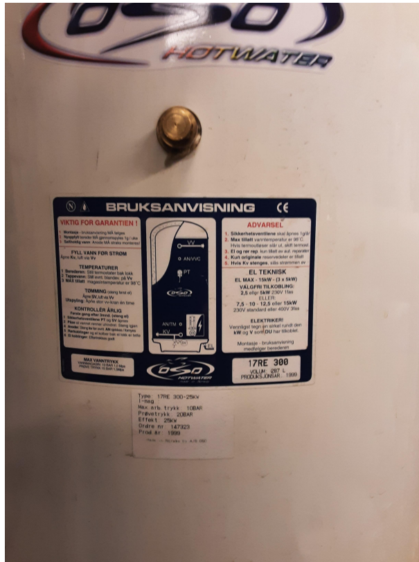
Skjema: "Risikovurdering Legionella : BL25" Spørsmål: BEREDER(E), Prod.år, volum, temp.? Beskrivelse: Bereder i varmesentral, Filnavn: IMG_20220920_114823.jpg
