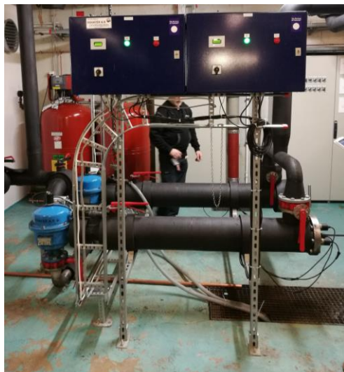
Fra venstre: nøddusj, system for UV-bestråling av forbruksvann og filterhus over himling
