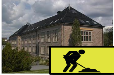
W.C. Brøgger hus Bygges 2015-2020
