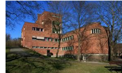
Utvendig rehab Svein Rosselands hus - slutfase
