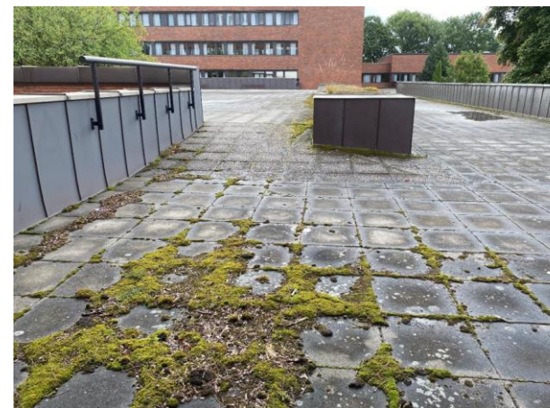
I-Lab og tak på Kjemibygningen – PÅGÅR!
