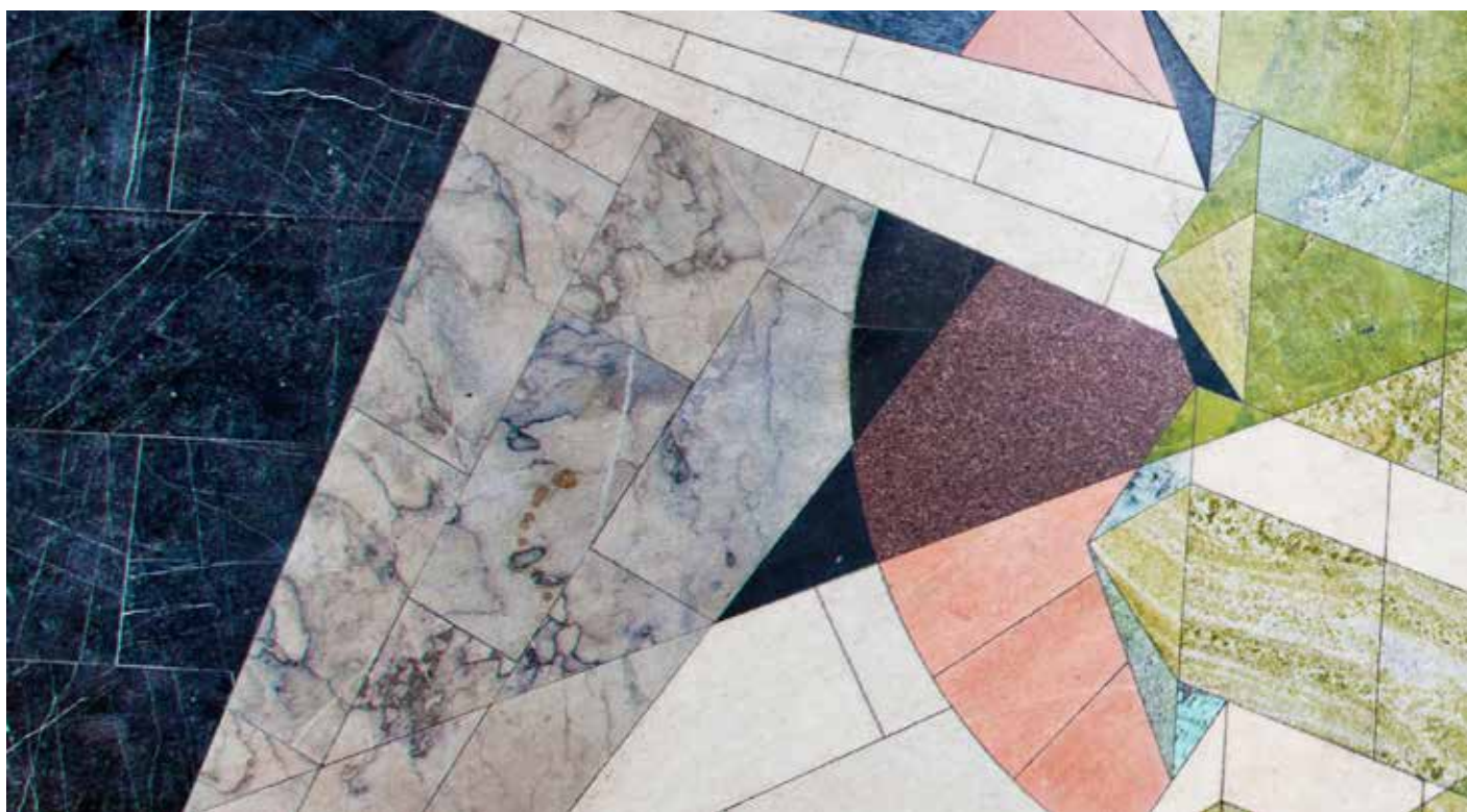
I Geologibyggets vestibyle er gulvet i belagt med 139 ulike steinsorter i et mønster tegnet av arkitekt Finn Bryn. Gulvet fungerte både for undervisningsformål og som en særegen prøvecatalog for kommersielt tilgjengelig norsk naturstein.
