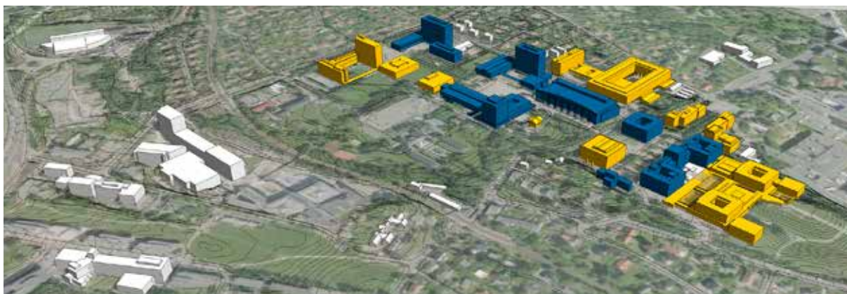
FIG. 11: Rundt 70 % av fasadene på UiOs bygninger og en del interiører er fredet eller vernet. Figuren viser UiO:Blindern, der blå bygninger er fredet og gule vernet.
