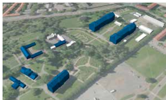
FIG. 13: De aller fleste bygningene ved UiO:Tøyen er fredet.
