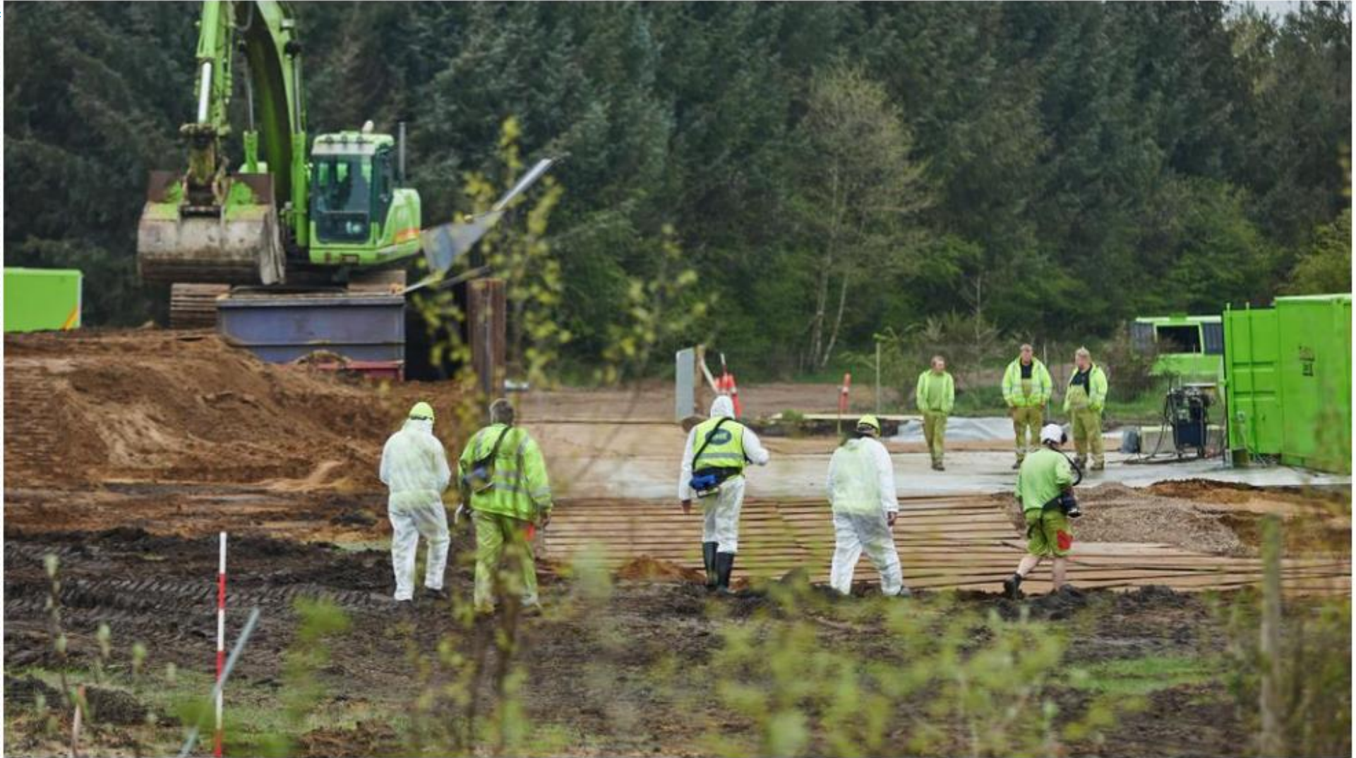
Tonnevis av døde mink måtte graves opp igjen våren 2021 for å unngå forurensing av grunnvannet. Foto: Mikkel Berg Pedersen / Ritzau Scanpix / NTB
