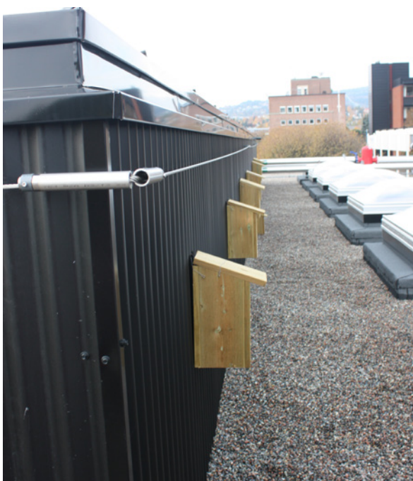
Sophus Bugges hus: For å legge til rette for biologisk mangfold på campus, er det satt opp fuglekasser på taket.
