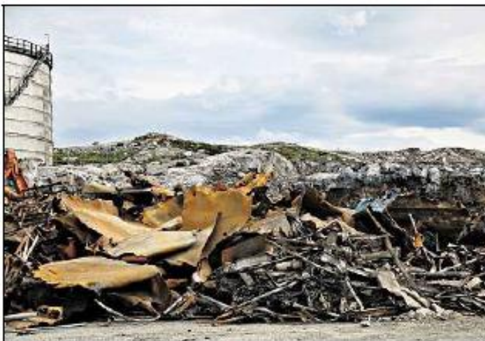
Vest Tank-ulykken i Gulen i Sogn og Fjordane gjorde store skader på renseanlegget – og på miljøet.
