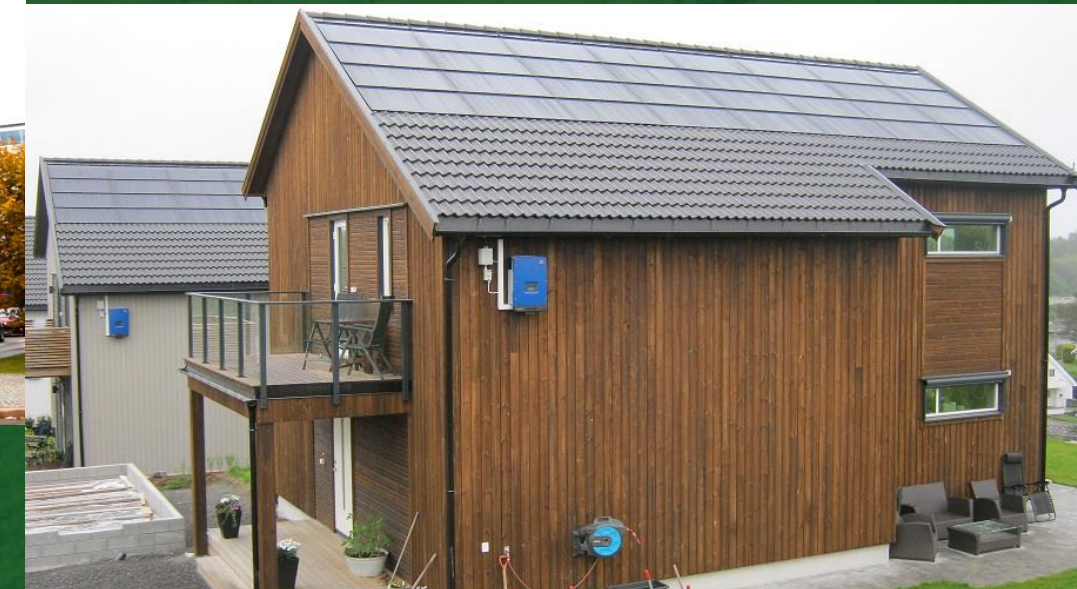
Smart Village Skarpnes Passivhus med BIPV på tak
