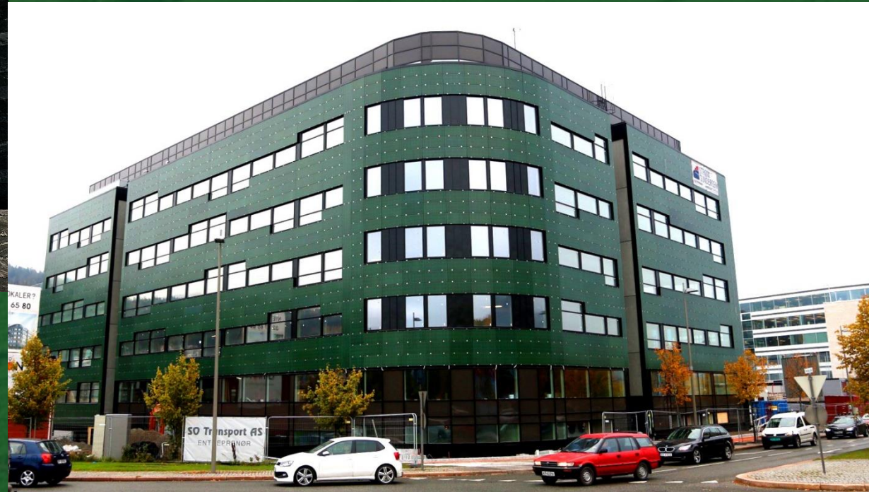
Solsmaragden i Drammen kledd med grønne solceller
