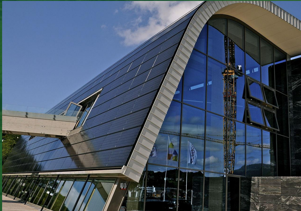
Kultursenteret Oseana med solceller i fasadeplatene
