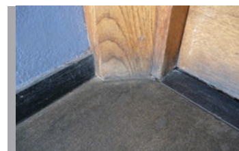
Detalj av gulv og fotlist
