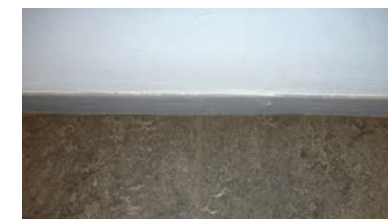
Linoleumsbelegg på gulvet
