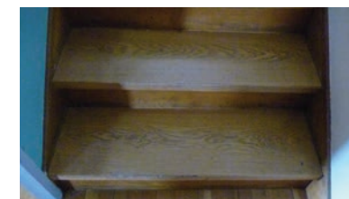
Trapp opp til 4. etasje
