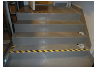
Støpt betongtrapp mot korridor
