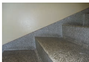
Trapp med terrazzodekke
