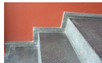
Trapp utført i terrazzo
