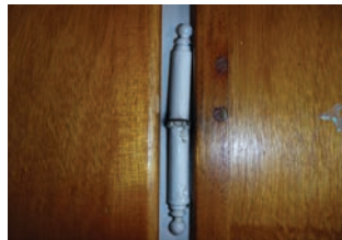
Detalj av dør
