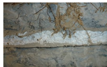
Oppbygging av fundamentet
