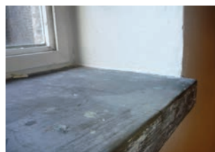
Malt betongkarm
