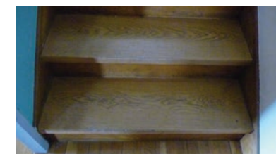
Trapp opp til 5. etasje
