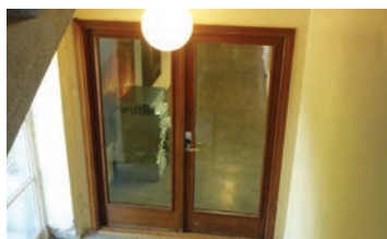
Dør til korridor
