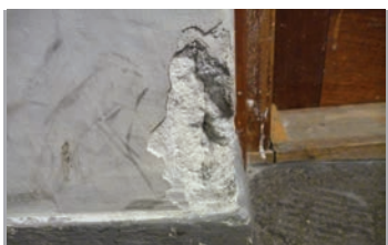
Detalj av kalkpusset murvegg
