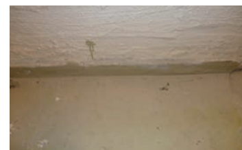
Malt betonggulv i K06
