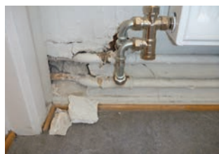
Gulv og radiatorrør
