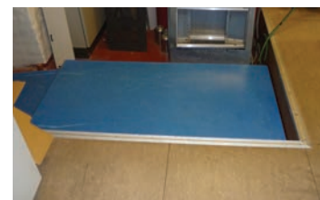
Oppforet gulv i 112 for ventilasjon
