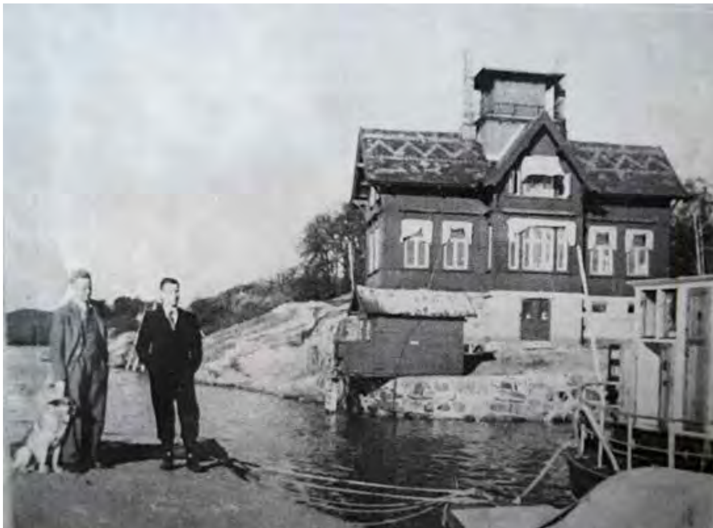
Fotografi fra 1948 som bl.a. viser mønsteret i det opprinnelige skifertaket. Bildet viser også at tårnet er bygd om med nytt panel og rekkverk, og at pipene er endret. Foto: Avfotografering av innrammet fotografi på Biologen
