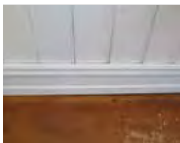
Lakkert avrettingsmasse på gulvet
