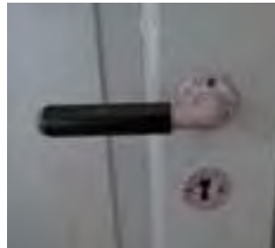
Dør inn til tilbygget.
