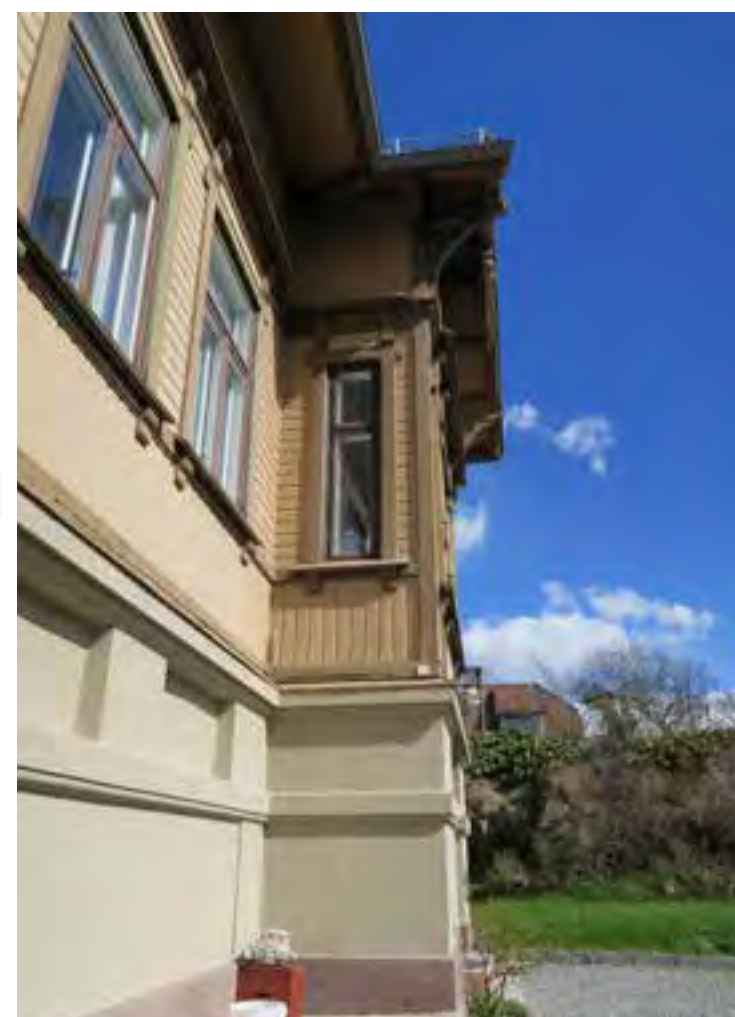
Sokkelmuren er pusset og malt.
