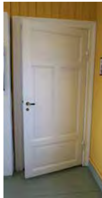
Dør inn til rom 103
