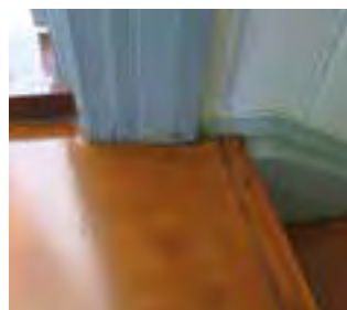
Detalj av gulvbelegget
