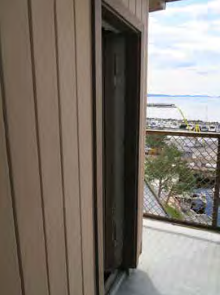
Tårnoppbygget med nettingrekkverk
