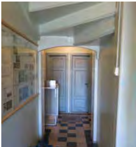
Gangen sett mot rom U04 og toalett dørene der.
