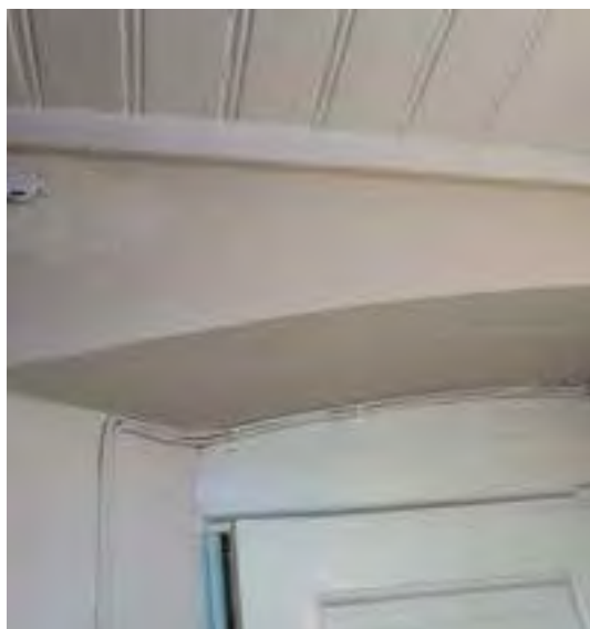
Døra er montert i murnisjen ut mot gangen.
