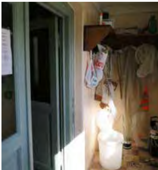
Vindfanget med opprinnelig dør og gulvfliser
