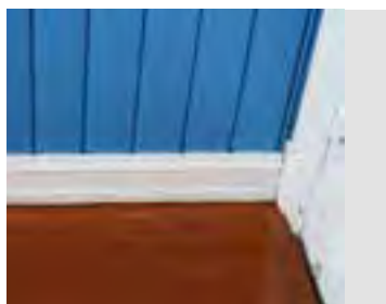
Støpt og lakkert gulvbelegg
