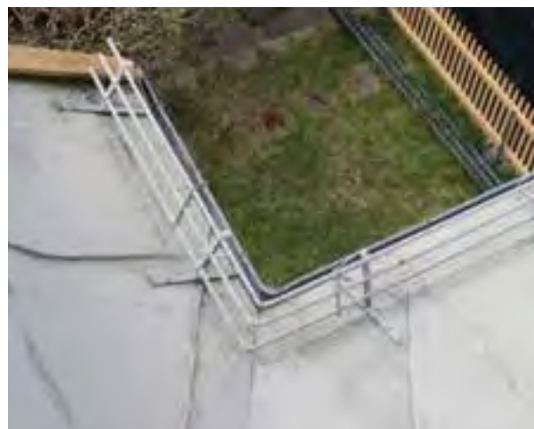
Detalj av taktekking og snøfanger
