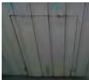
En av fire luker inn til kryploft
