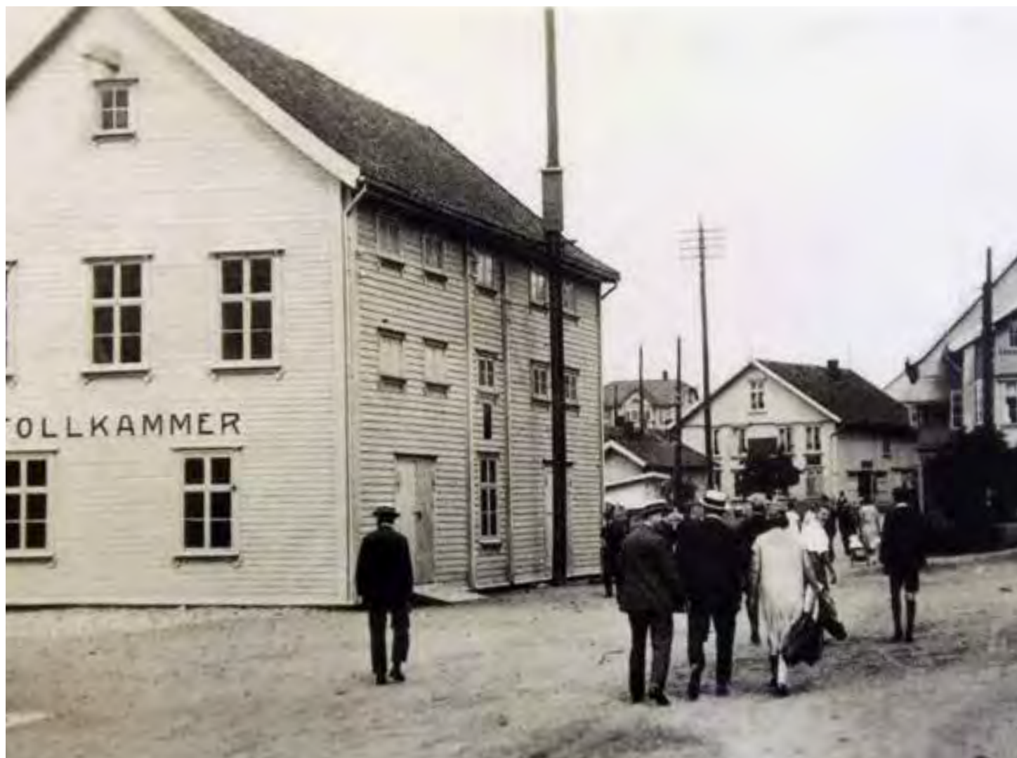
Til venstre: Tollboden ca. 1920. Vi ser at lasteporten i søndre gavl er fjernet, og at bygningen har fått tre vinduer i 2. etasje. Bildet viser også østfasadens opprinnelige utforming, med to lasteramper/porter. Til høyre: Tollboden tidlig på 1960-tallet (før universitetet overtok i 1964). Skiltet med inskripsjonen "Tollkammer" er fjernet, men det offisielle flagget vaier fortsatt. Vi ser også at vinduene i første etasje har gitter på innsiden. Begge bildene er funnet på Tollboden og tilhører UiO.
