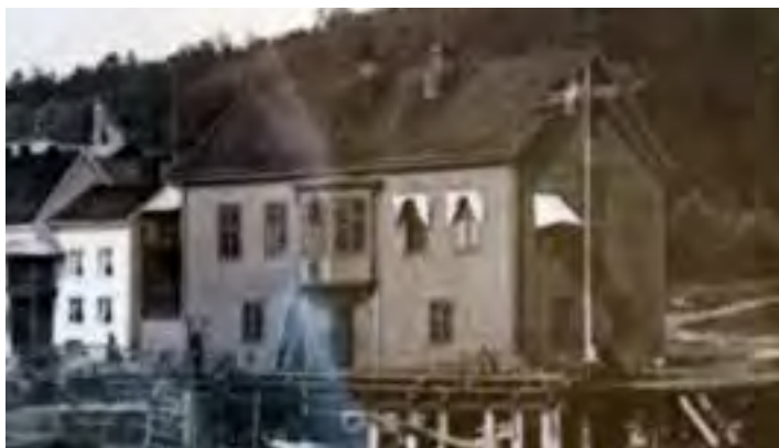
Utsnitt av innrammet bildet som henger på veggen i Tollboden. Bildet er fra 1903 og viser vest- og sørfasaden. I gavlen mot sør er det en vinsj oppunder mønet for innlasting av varer. Under vinsjen er det en lasteport som senere ble fjernet.
