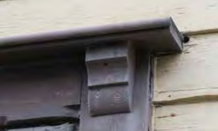
Vannbrett med beslag og profilert konsoll
