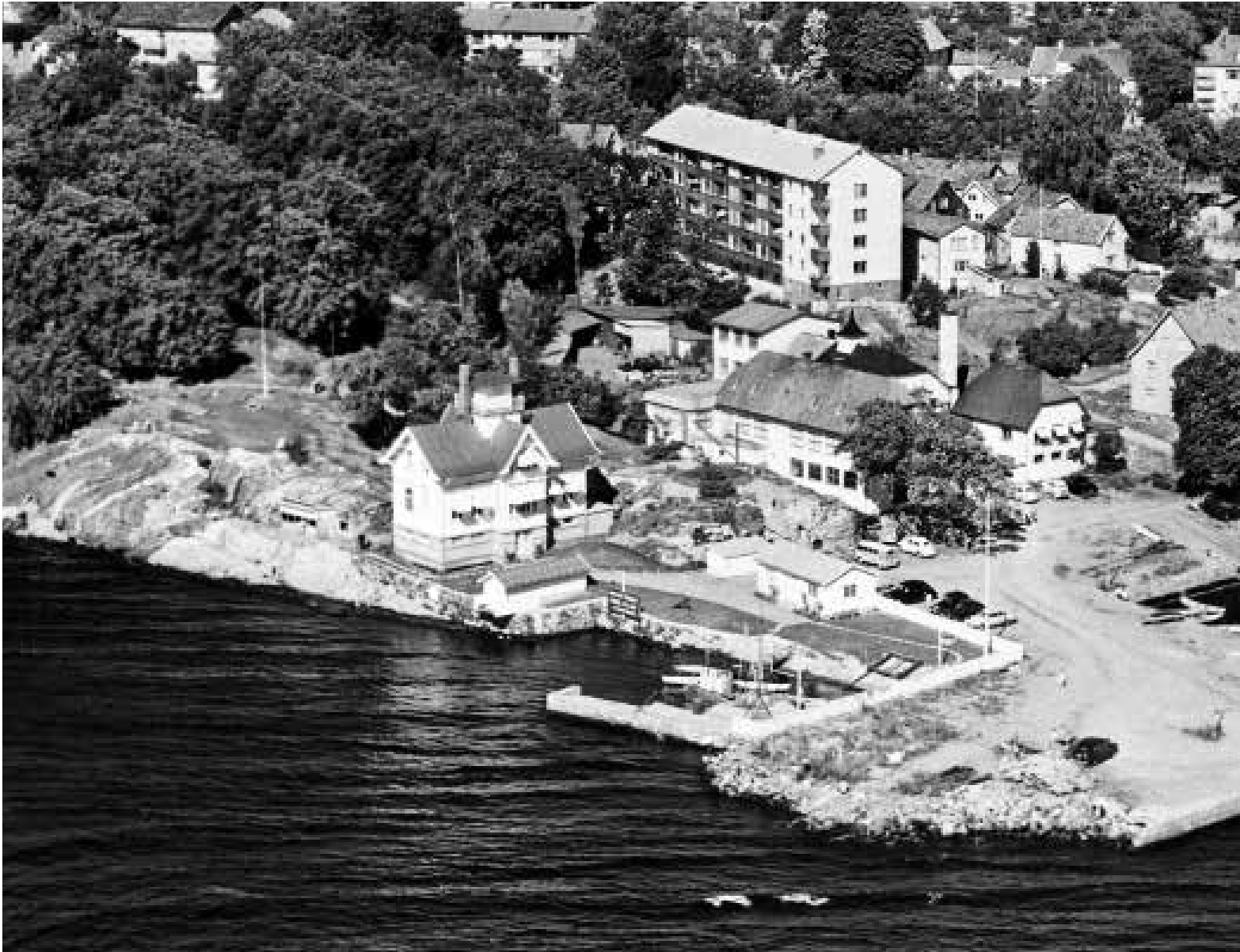
Flyfoto av eiendommen fra 1961. Deler av fjellknatten er sprengt bort, badehuset er forlenget og uthusene er oppført. Hagen er opparbeidet med plenområder, grusplass og hellelagte ganger. Vi ser også at steinbryggene er noe endret og at det er etablert en natursteinsmur langs deler av kaifronten. Foto: Museene i Akershus (MiA).
