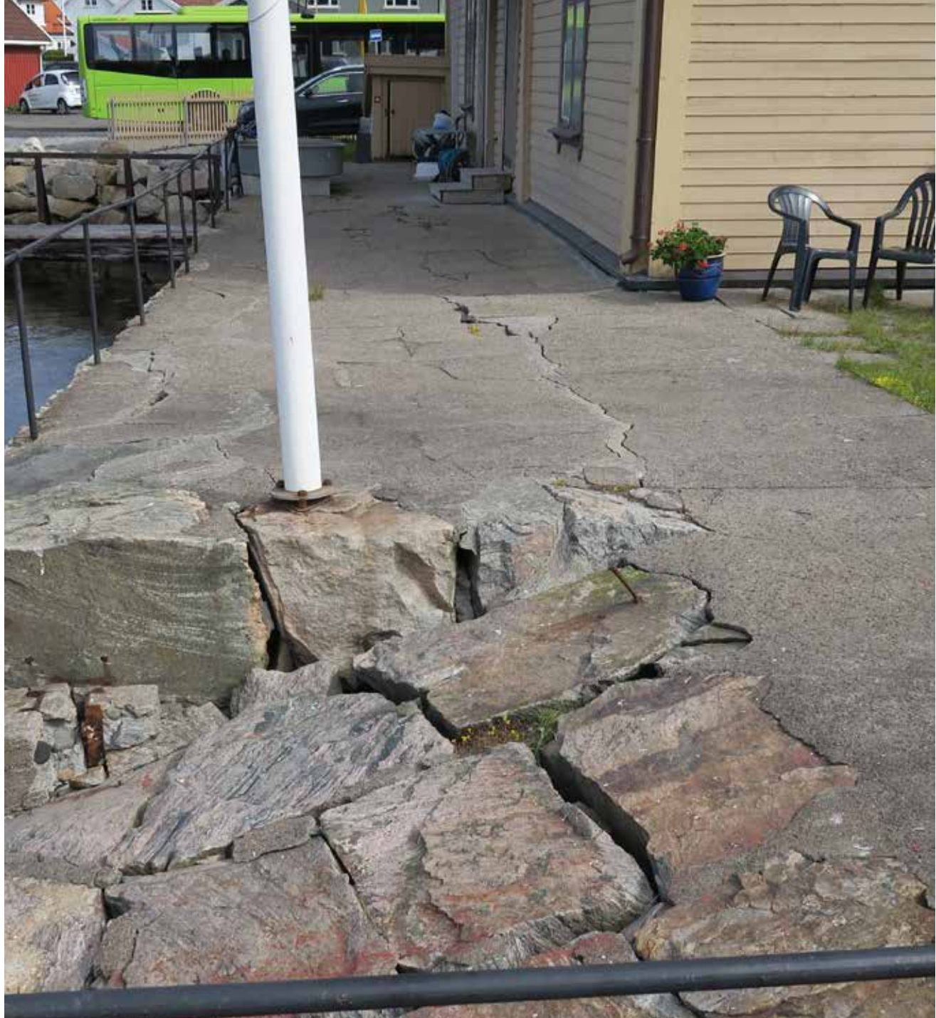
Parti fra Tollboden som viser deler av beddingen og steinbrygga på vestsiden av bygningen.
