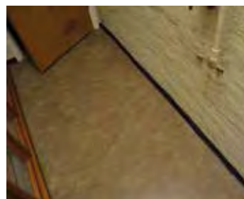
Gulvet i rom 446 er belagt med vinyl.
