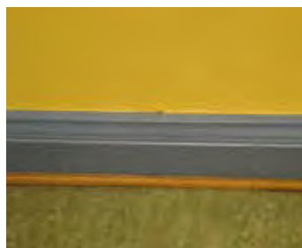
Nyere, profilert fotlist, vaskelist og vinylbelegg.
