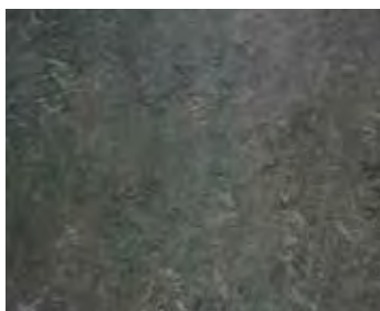
Gulvene er belagt med nyere vinyl.
