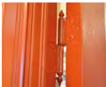
Trolig opprinnelige hengsler til rom 401.
