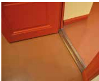
Gulvene er belagt med eldre linoleum.
