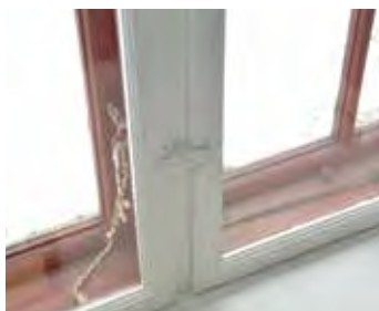
Eldre varevindu på innsiden av opprinnelig vindu.
