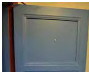
Malt fyllingsdør fra pauserom til trappe-rom.
