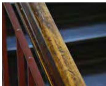
Håndlist av tre, rekkverk av malt stål.
