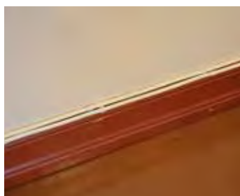
Nyere, profilert fotlist. Gulvet er belagt med linoleum.
