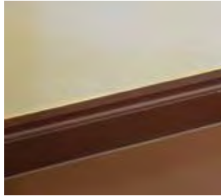
Gulvet er belagt med nyere linoleum. Nyere, profilerte fotlister.
