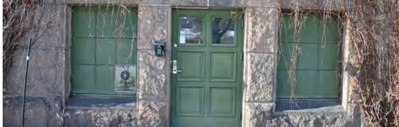
Inngangsparti i sokkeletasjen. Vinduene er malt igjen.
