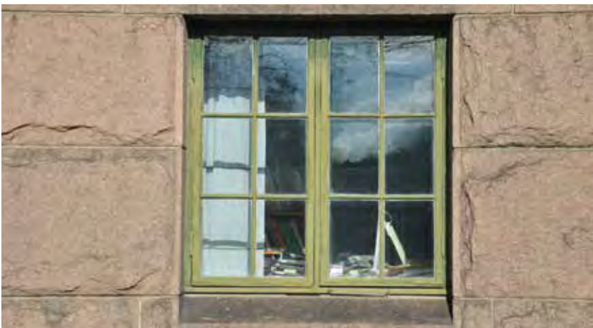
Eksempel på opprinnelig vindu i sokkeletasjen.
