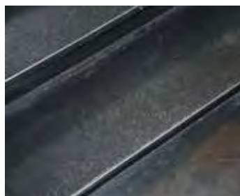
Støpte trinn med tilslag av småstein.
