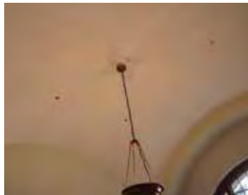
Himlingen i vestibylen er pusset og malt.
