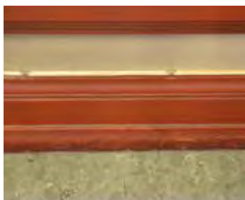
Gulvet er belagt med vinyl. Malt fotlist av tre.
