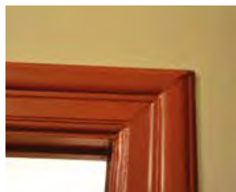
Gerikter rundt døråpning til rom 448.
