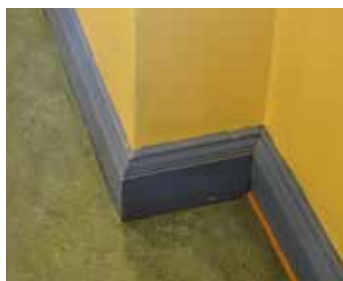
Gulvet er belagt med vinyl, fotlist av tre.
