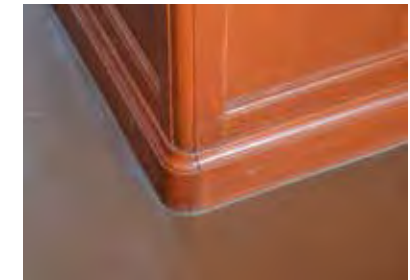
Gulvet er belagt med nyere linoleum.
