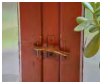
Detalj fra de eldre varevinduene.
