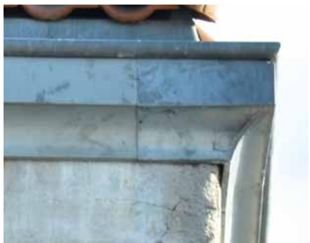
Gesimsen har beslag av sink.
