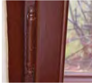
Hengsler på varevinduene.
