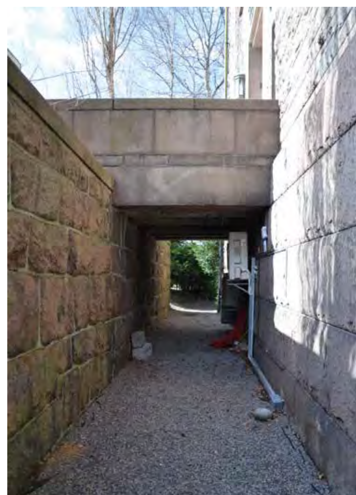
Inngangspartiet i syd sett fra undersiden. Fasade mot syd til høyre.
