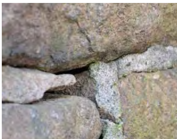
Detaljbilde av granittmuren mot syd
