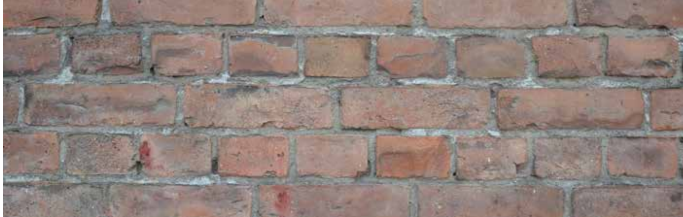
Detaljbilde av blankmuren på galvfasaden mot nord
