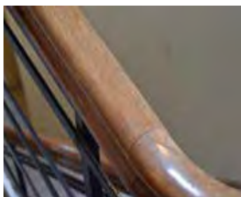
Rekkverk av lakkert tre
