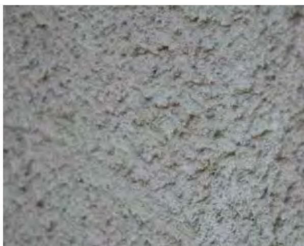
Detalj av forblending foran vinduene i sokkeletasjen mot øst
