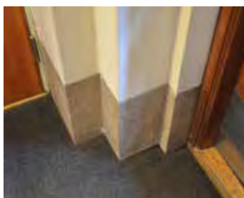
Nedre del av veggen er kledd med granitt.
