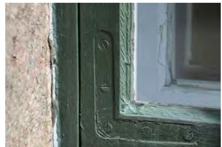
Eldre vindu med innfelte hjørnejern, trolig fra 1960-tallet.
