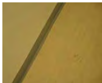
Gulvet i WC er belagt med eldre vinyl.
