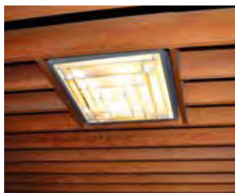
I himlingen er det spiler av tre med innfelt belysning. Trolig fra 1960-tallet.
