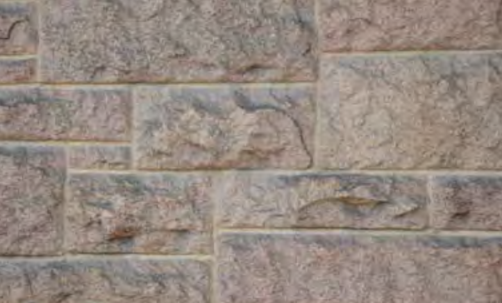
Fasaden er forblendet med granittstein lagt i dekorativt mønster.
