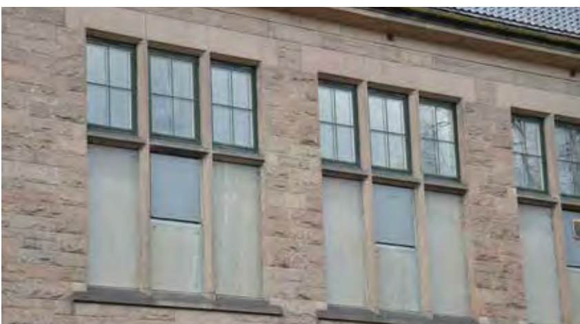
Vinduer i 2. etasje mot øst, delvis forblendet med skiferplater.
