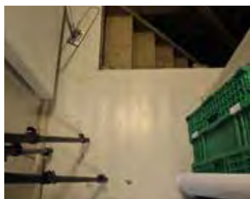
141: Trapp ned til kjelleren.
