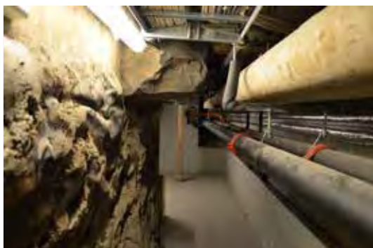
Over: Korridoren mot øst. Gulv og vegger er av støpt betong. Under: Korridoren sett mot vest. Natursteinsmur til venstre.
