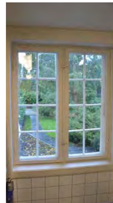
Det er nyere gerikter rundt vinduet.
