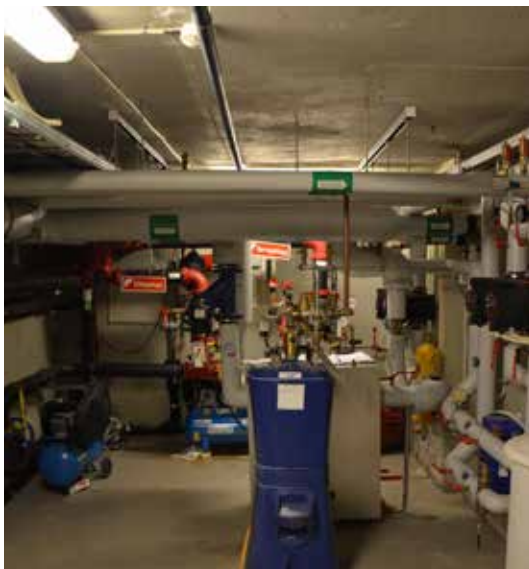
Over: Rommet sett fra døråpningen, preget av nyere overflater.
