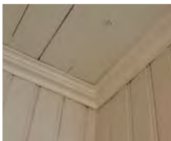
Vegger og himling er kledd med panel.
