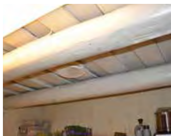
Kraftig vekselpanel og rundtømmer.
