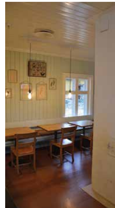
Trolig en opprinnelig skorstein til høyre.
