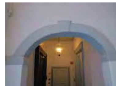
Portal fra trapperommet mot vindfanget.
