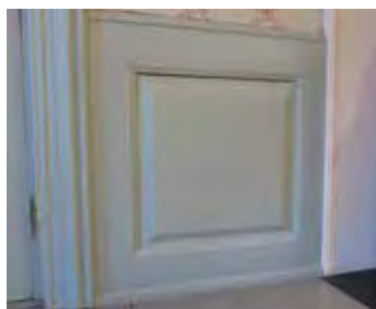
Brystning med profilerte fyllinger.
