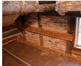
Den ene gavlveggen på loftet.
