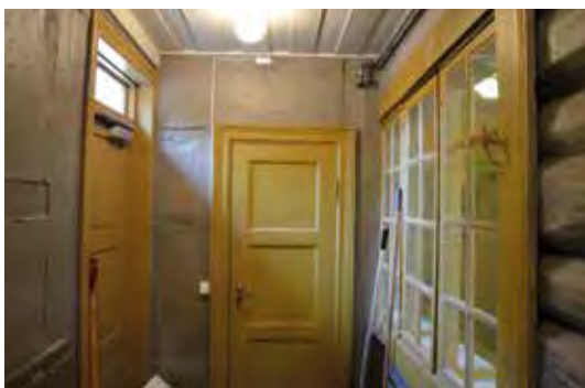
Under: Rommet sett mot nord.
