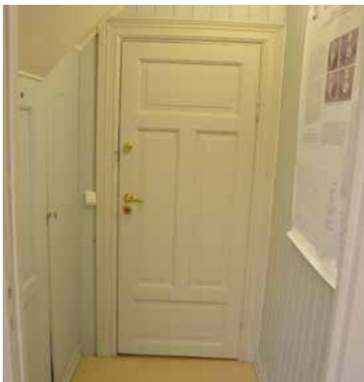
Over: Forgang til kontor 215. Eldre panel på veggene.
