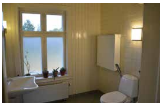
Under: Rommet sett fra korridoren.
