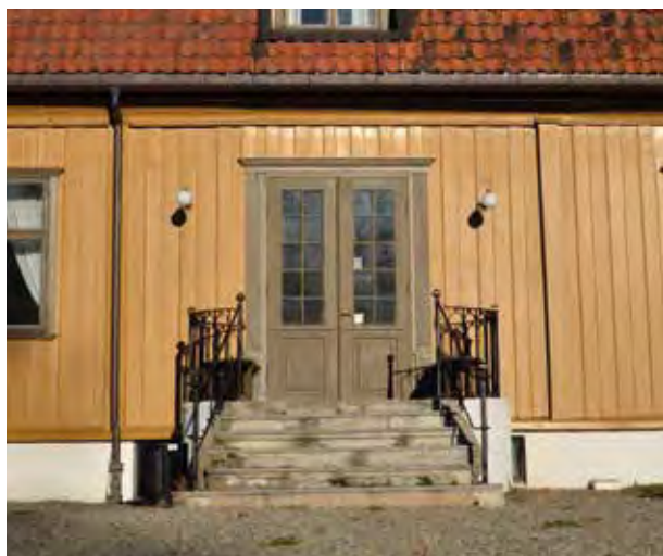
Dagens situasjon – trappen og ytterdøren fra hagestuen.
