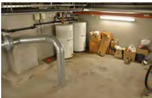
Under: Kjelleren rom 040, brukt til lager og teknisk rom.
