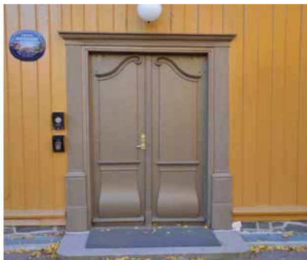
Dagens situasjon – ytterdøren mot tunet.
