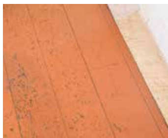
Gulvet er nyere gulvbord av tre.
