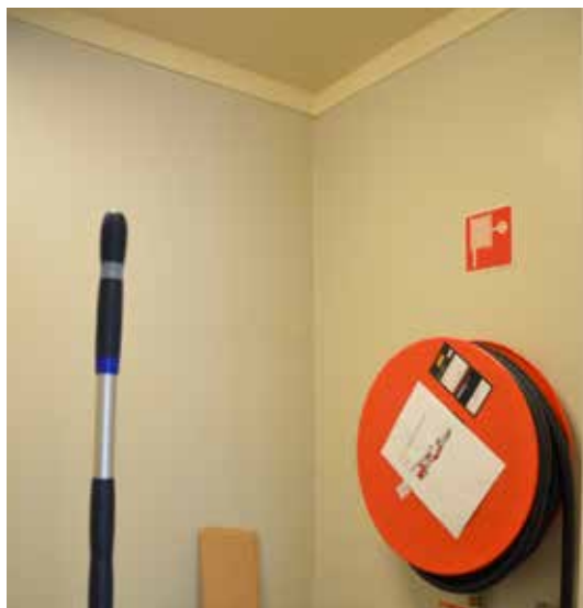
Over: Veggene og himlingen i kottet er kledd med malte plater.
