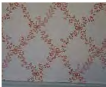
Veggene er trukket med strie og tapet.
