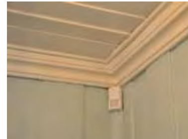
Kraftig, profilert taklist og hulkil.
