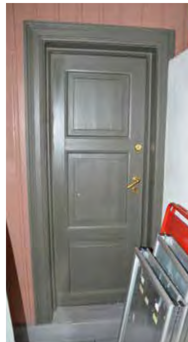
Eldre dør mot rom 135.
