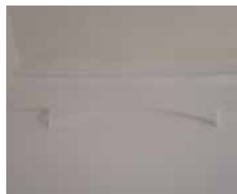
Detalj på brannveggen under himlingen.
