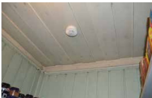
Over: Veggene er kledd med eldre, malt panel. Nyere hyller. Under: Himlingen er kledd med eldre, malt vekselpanel.
