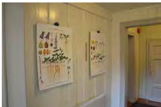
Under: Eldre panel på veggene malt med linoljemaling.
