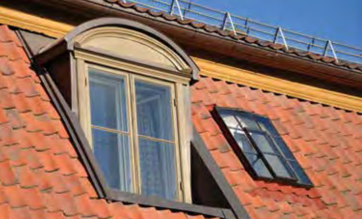
Arkvindu i hovedfløyens 2. etasje. Takvindu av jern ved siden av.
