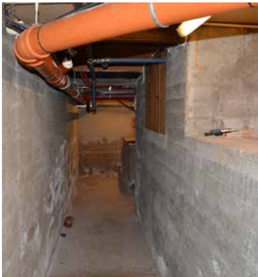
Over: Kjelleren under kaféen sett fra trappen. Nye overflater.
