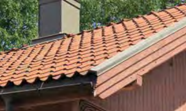
Nyere takteking av enkeltkrum tegl. Opprinnelig teglpipe er kledd med beslag.
