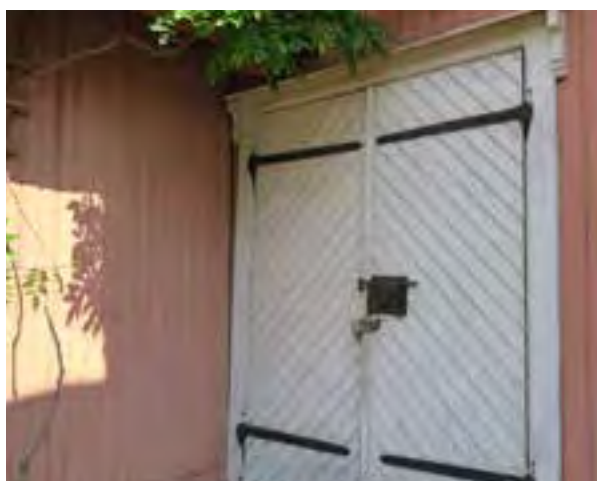
Tofløyet labankdør med fiskebeinspanel
