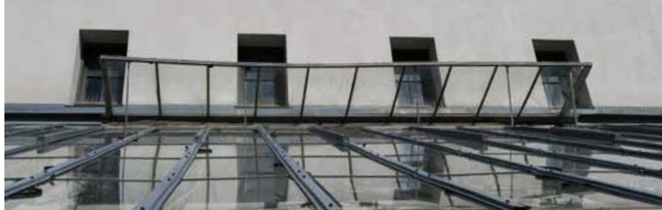
Taket over Middelhavsklimarommet
