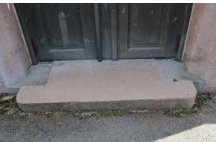
Granitt-trinn foran inngangsdørene
