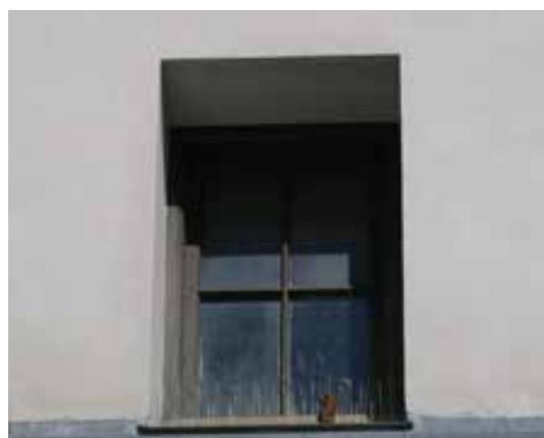
Vindu i sørfasadens 2. etasje
