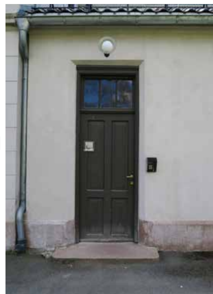
Dør i nordfasaden
