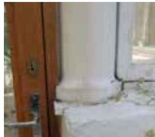
Bærende jernsøyle mellom dør og vindu.
