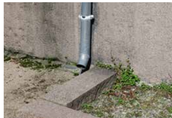
Nedløp av sink
