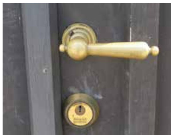
Detalj av dør inn til Middelhavsklimarommet (vestgavlen)
