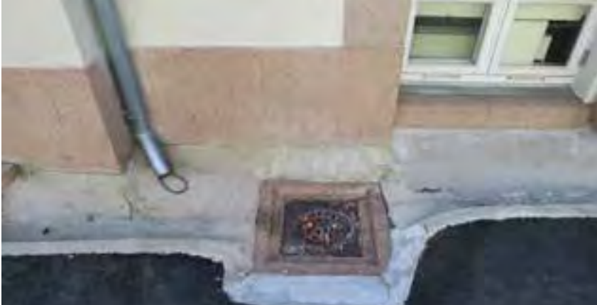
Nedløp og sluk på nordsiden
