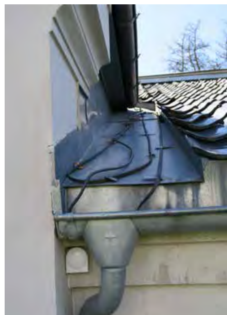
Detalj av tak med varmekabler langs beslag og i renne og nedløp
