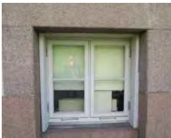
Et av to vinduer i nordfasaden
