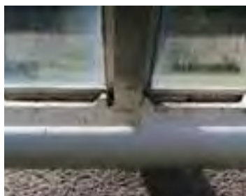
Overgang mellom vegg og tak
