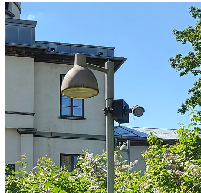
Både kamera og mast bør erstattes med en ny helhetlig løsning
