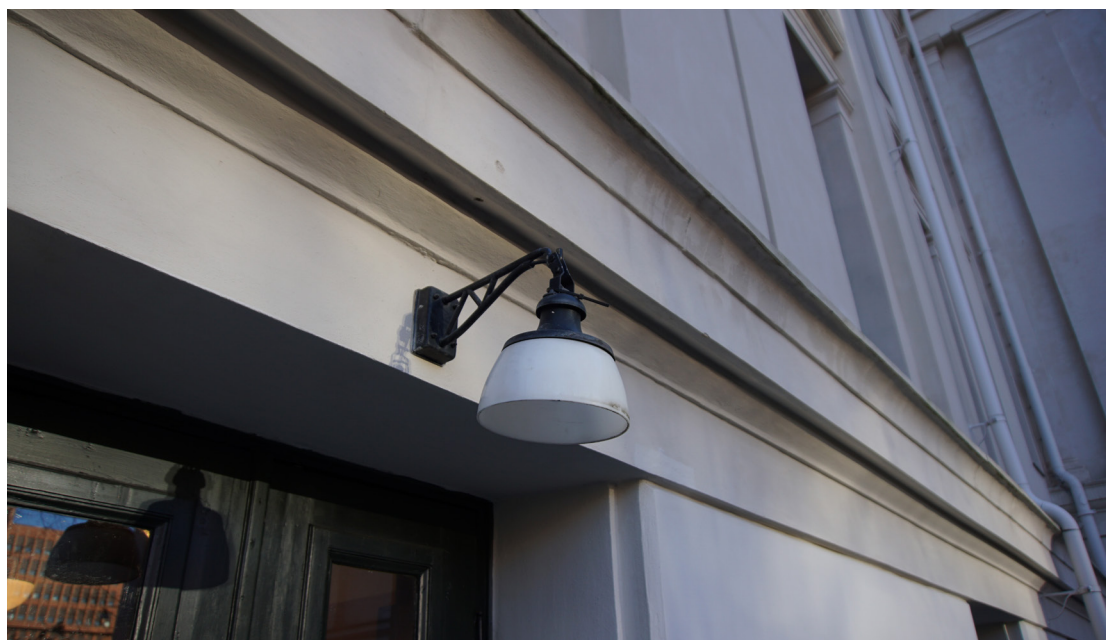
Alle identitetsskapende armaturer må oppgraderes med LED lyskilde for å få et helhetlig uttrykk og bedre funksjonalitet
