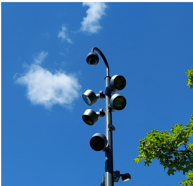
En spesiallaget "svanehals" for integrering av kamera i Frederiks gate
