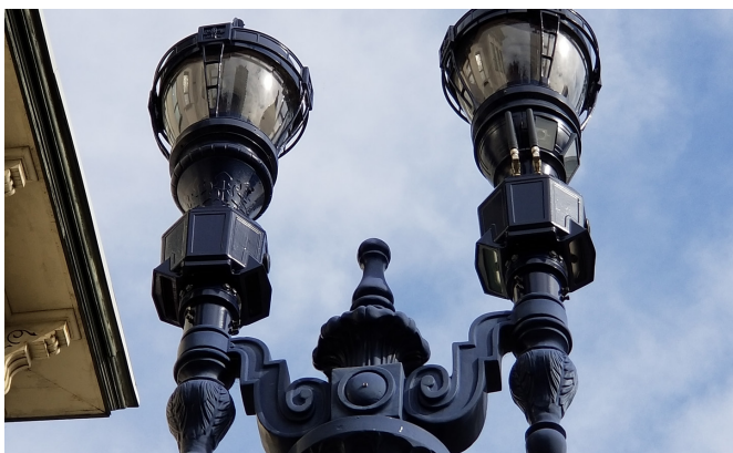
Historisk mast med integrerte kameramoduler, foto: Maury Wright
