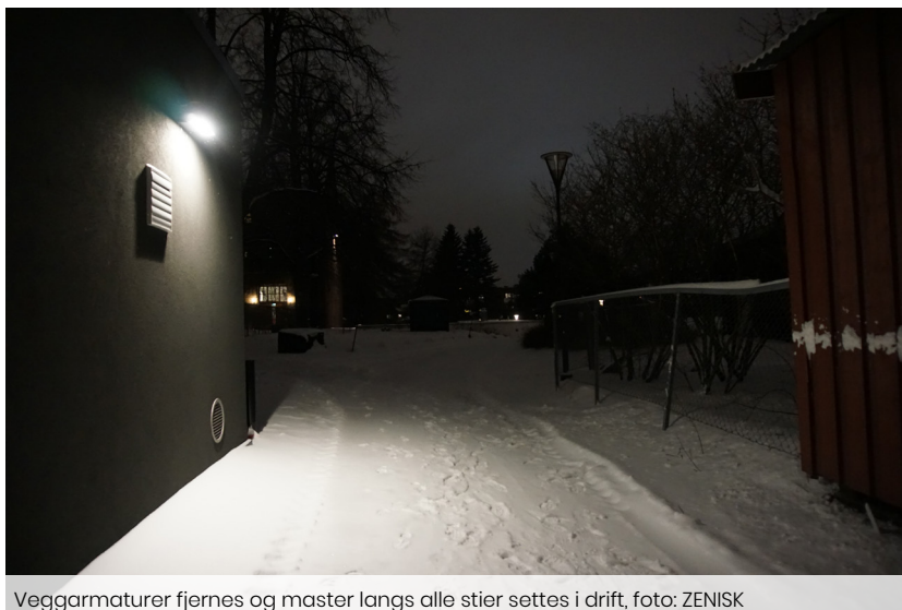
Veggarmaturer fjernes og master langs alle stier settes i drift, foto: ZENISK
