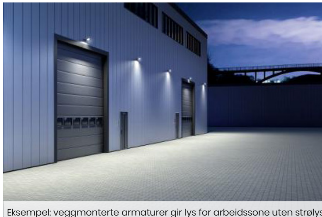
Eksempel: veggmonterte armaturer gir lys for arbeidssone uten strølys
