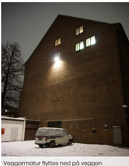
Veggarmatur flyttes ned på veggen
