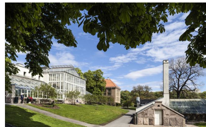
Veksthusene: oppgradering av eksisterende lys foran innganger
