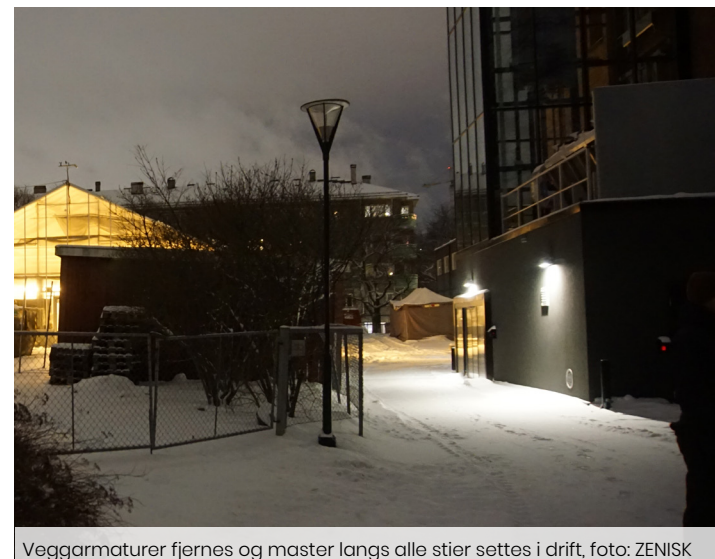
Veggarmaturer fjernes og master langs alle stier settes i drift, foto: ZENISK
