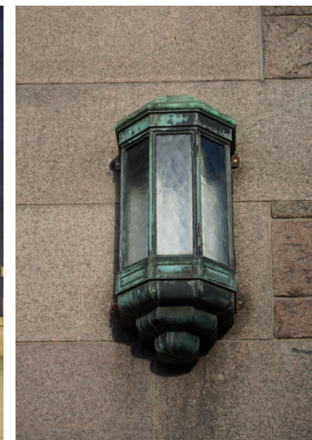
Veggarmaturer ved inngangspartiene til museumsbygningene oppgraderes med LED lyskilde, evt med funksjonslys under, foto: ZENISK
