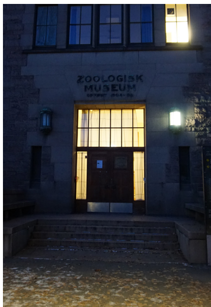
Veggarmaturer ved inngangspartiene til museumsbygningene oppgraderes med LED lyskilde, evt med funksjonslys under, foto: ZENISK
